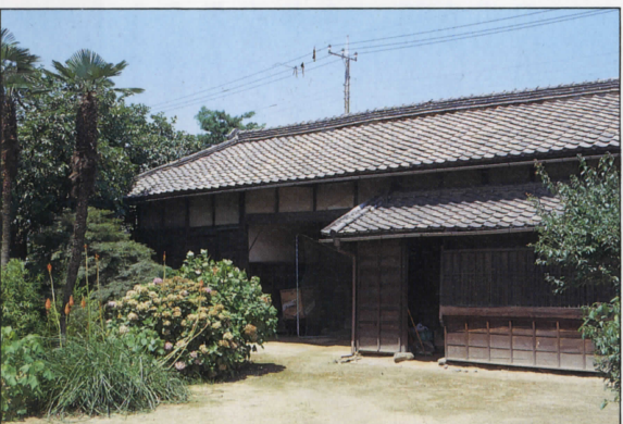
内側から見た石井家の長屋門
