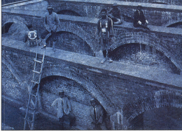
浄水場内に築造中の配水池
